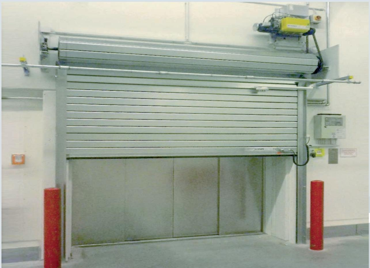
Aqua-Steel® T90, einwandiges Feuerschutzrolltor mit Sprühwasserbeaufschlagung
