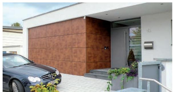
Flächenbündiges Tor bauseitig mit Fassadenplatten belegt
